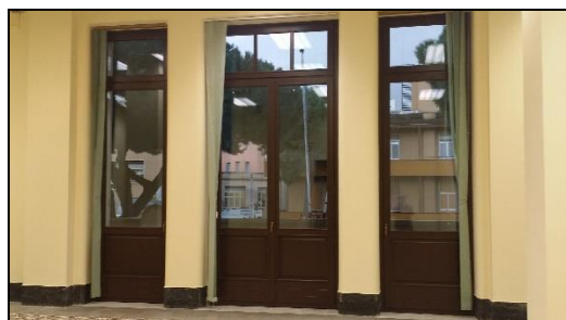
Veduta degli infissi esterni
