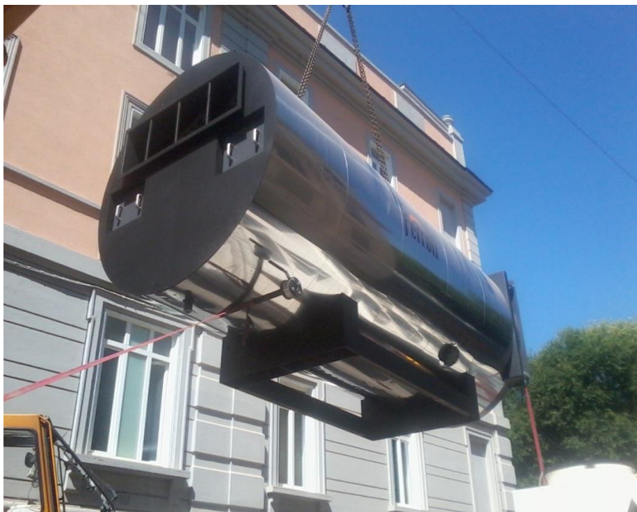
Movimentazione dei nuovi generatori
