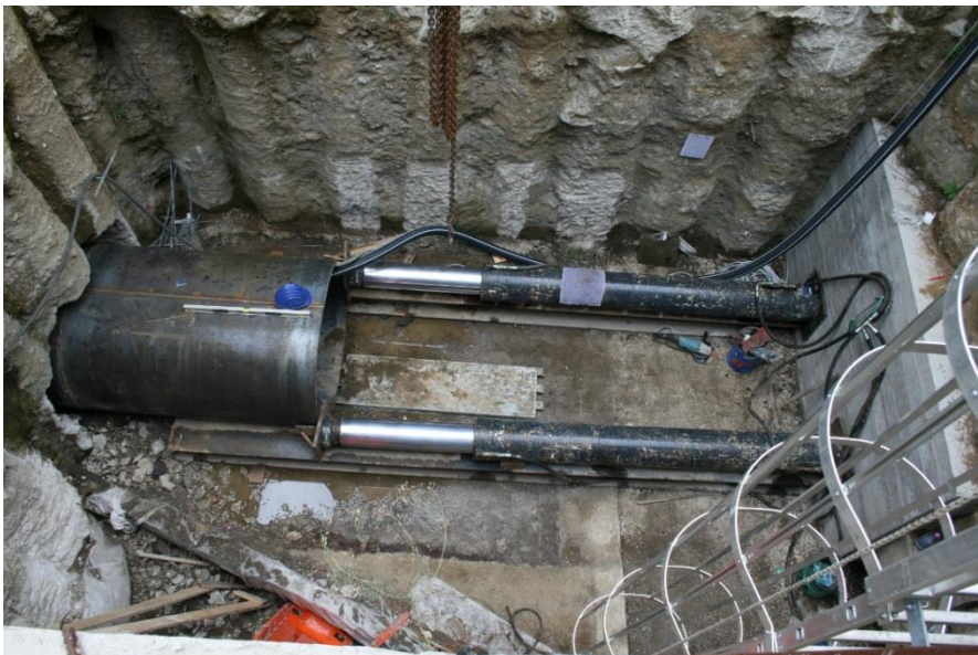
Posa delle tubazioni con tecnica del "microtunneling"
