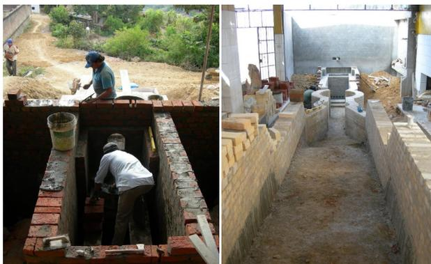
Construcción de la cámara de combustión (a la izquierda) y del conducto de humos (a la derecha)
