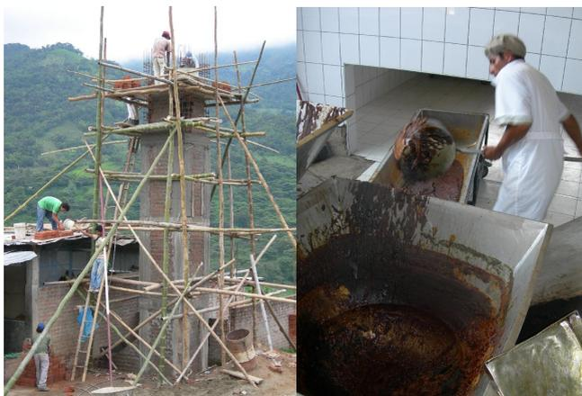
Construcción de la chimenea (a la izquierda) y producción de azúcar orgánica en el prototipo del nuevo horno (a la derecha)
