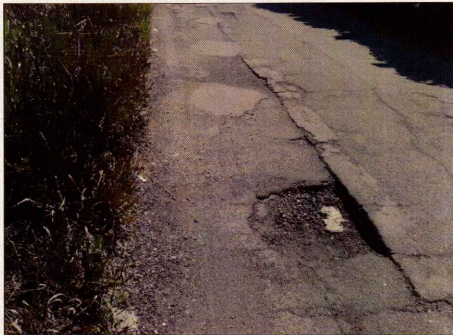
FOTO DELLO STATO DEL MANTO STRADALE ANTE OPERAM
