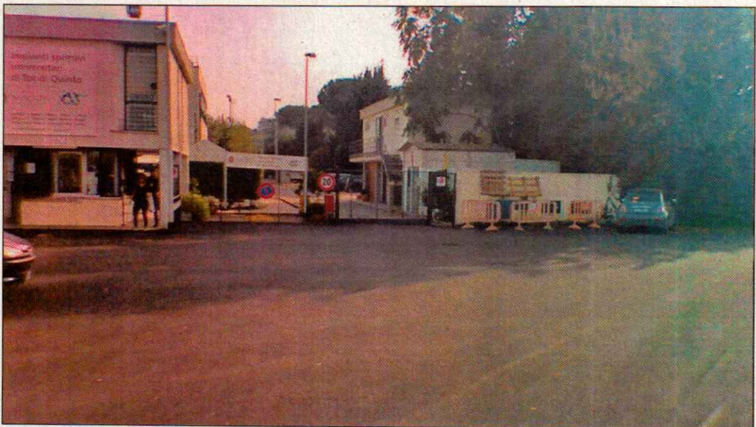
FOTO DELLO STATO DEL MANTO STRADALE POST OPERAM
