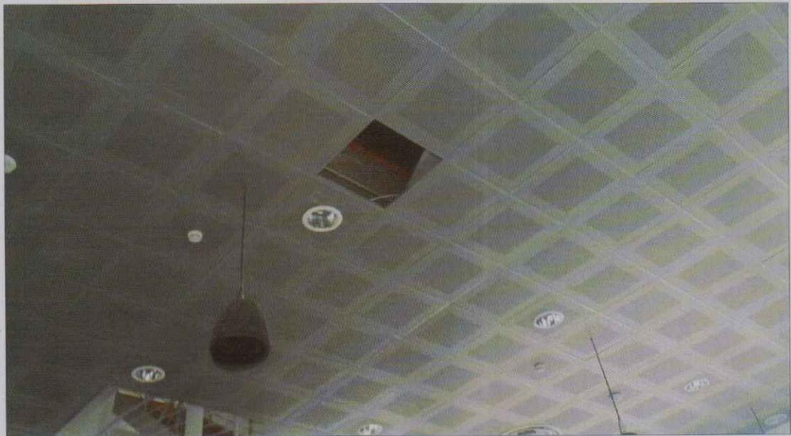
FOTO DEL CONTROSOFFITTO DELLA PALESTRA: INFILTRAZIONI D'ACQUA IN ALCUNI PUNTI
