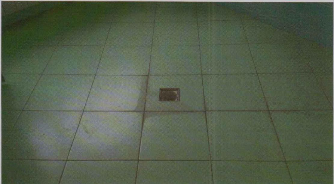
FOTO DELLO SPOGLIATOIO N. 3: POZZETTO DEL BAGNO SENZA LA GRIGLIA
