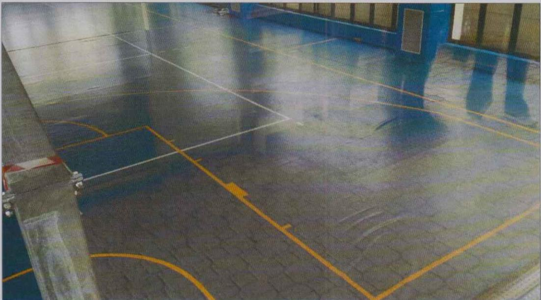
FOTO DELLA PAVIMENTAZIONE DELLA PALESTRA IN VARI PUNTI SCOLLATA E SOLLEVATA
