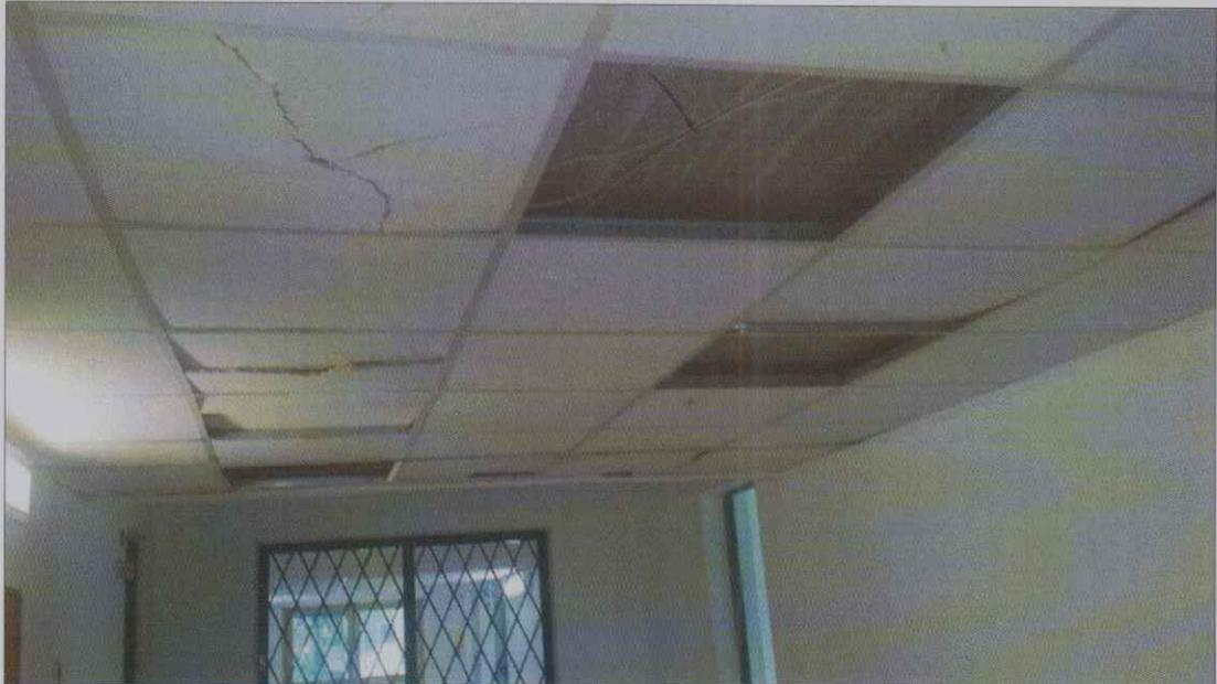
FOTO DEL CONTROSOFFITTO DEL CORRIDOIO DEGLI SPOGLIATOI AL SECONDO PIANO DELLA PALAZZINA B: PANNELLI DA SOSTITUIRE
