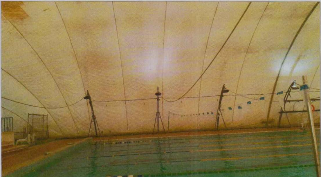
FOTO DELLA TENDOSTRUTTURA: PRESENZA DI ALCUNI PUNTI DANNEGGIATI E ALTRI GIA' RIPARATI. LA TENDOSTRUTTURA NON VERSA IN BUONE CONDIZIONI E NECESSITA DI SOSTITUZIONE
