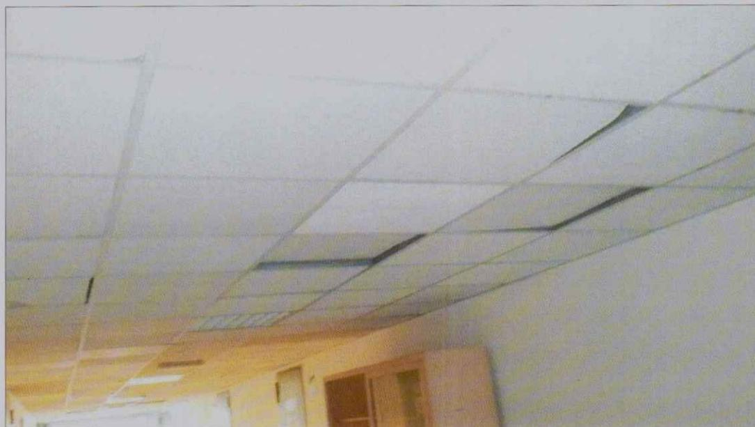
FOTO DEL CORRIDOIO DEL I PIANO DELLA PALAZZINA A – CARENZA NELLA PULIZIA DEI PAVIMENTI E DELLE PARETI, PANNELLI DEL CONTROSOFFITTO DANNEGGIATI
