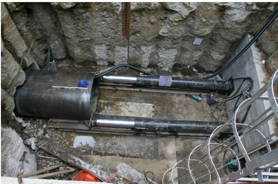
*Posa delle tubazioni con tecnica del "microtunneling"*
