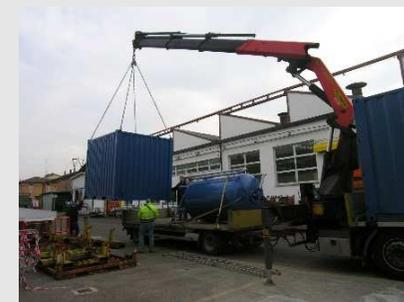
Fig. 4 Installazione unità di trattamento.
