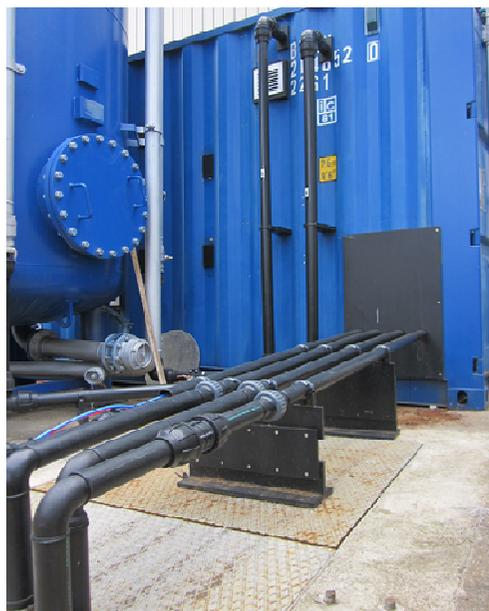
Fig. 1 Dettaglio collegamento pozzo - unità di trattamento.
