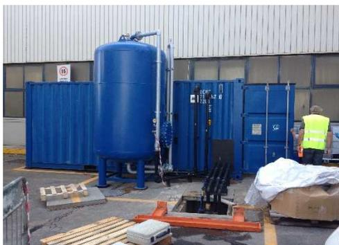
Fig. 2 Posizionamento unità di trattamento e collegamento con pozzo a ricircolazione.
