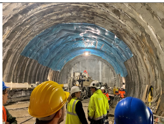
Brennero sotto-attraversamento Isarco
